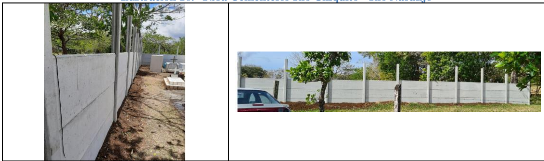
Ilustración 16. Obra Cementerio Río Chiquito - Río Naranjo
