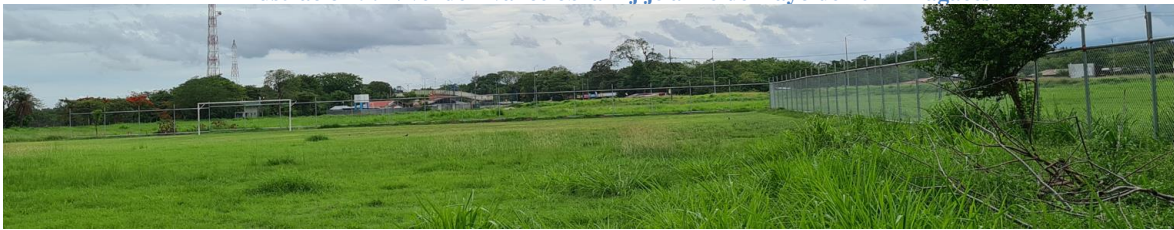
Ilustración 9. Nivel de Avance obra Pijije al 16 de mayo de 2022- Bagaces
