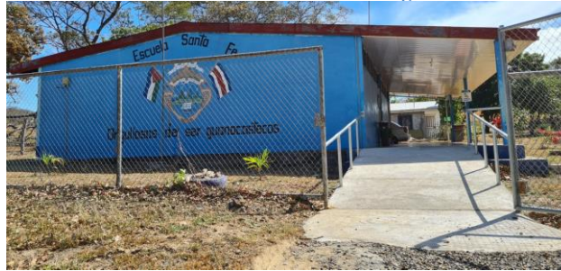
Ilustración 11. Obra Santa Fe - Bagaces
